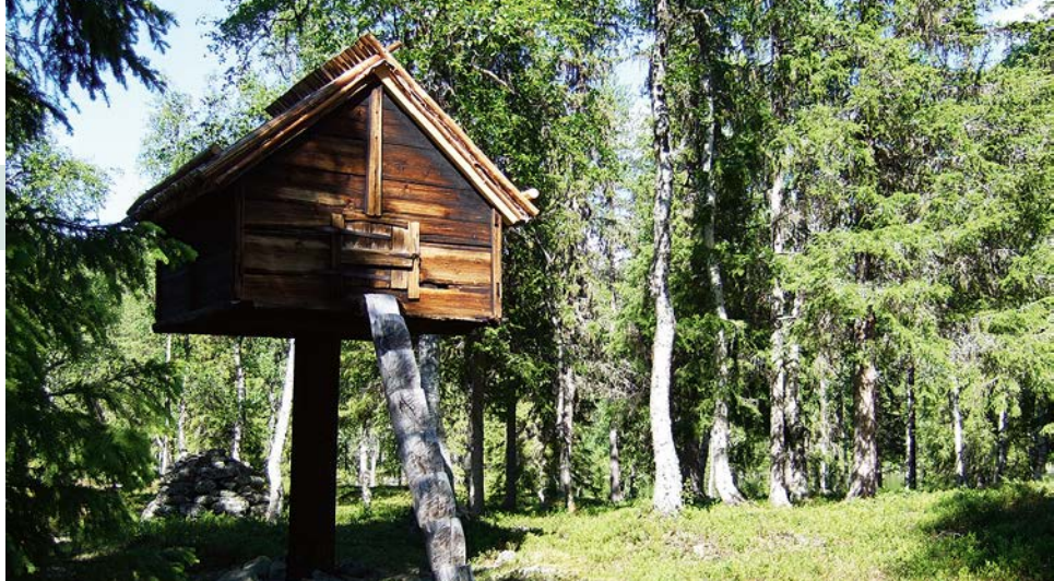
Njalla – en traditionell samisk stolpbod där man förr förvarade mat. Konstruktionen som vilar på en enda stolpe är gjord för att försvåra för djur som vill stjåla av maten. (foto Lena Maria Nilsson)
